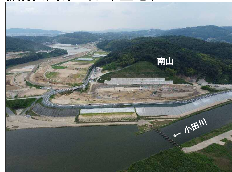
②南山掘削(高梁川より望む)
