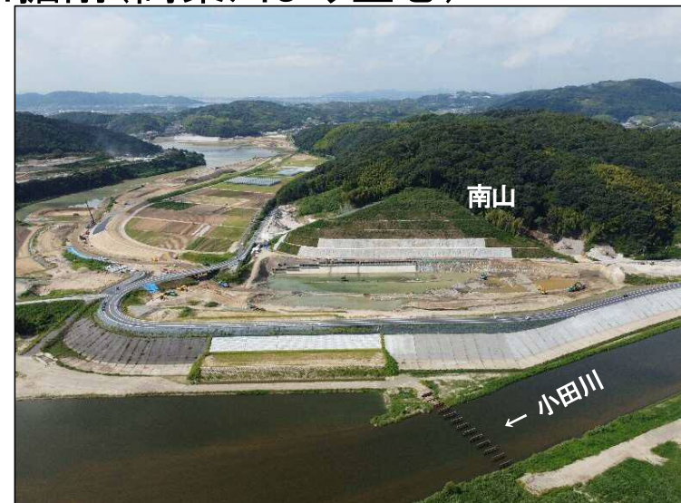
②南山掘削(高梁川より望む)
