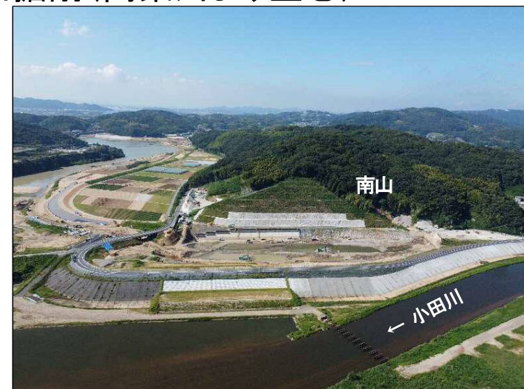
②南山掘削(高梁川より望む)
