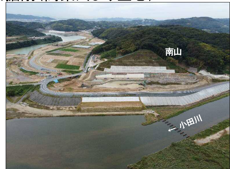
②南山掘削(高梁川より望む)
