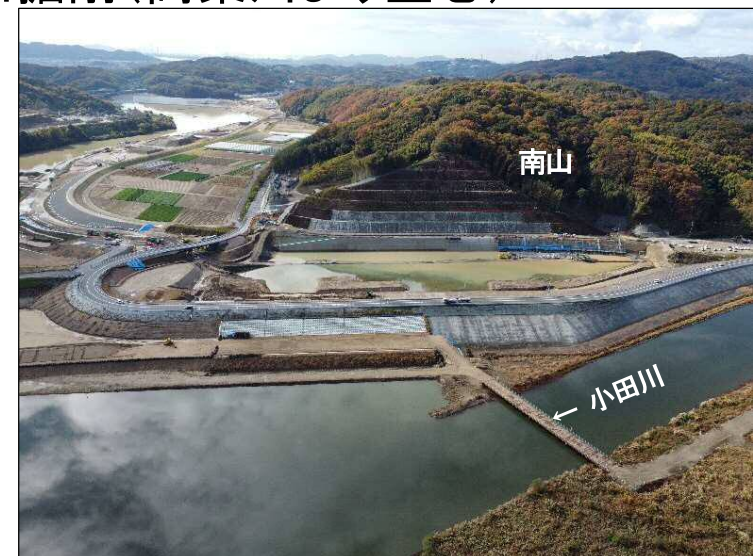
②南山掘削(高梁川より望む)
