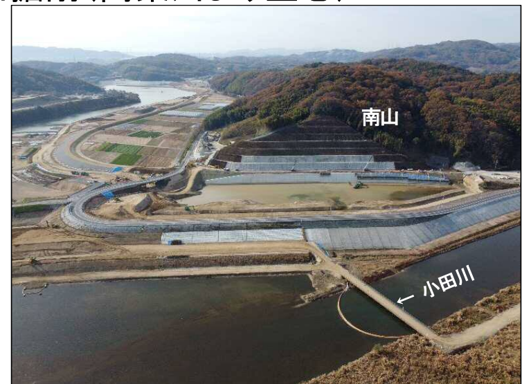
②南山掘削（高梁川より望む）
