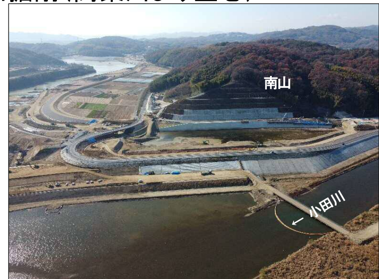
②南山掘削(高梁川より望む)
