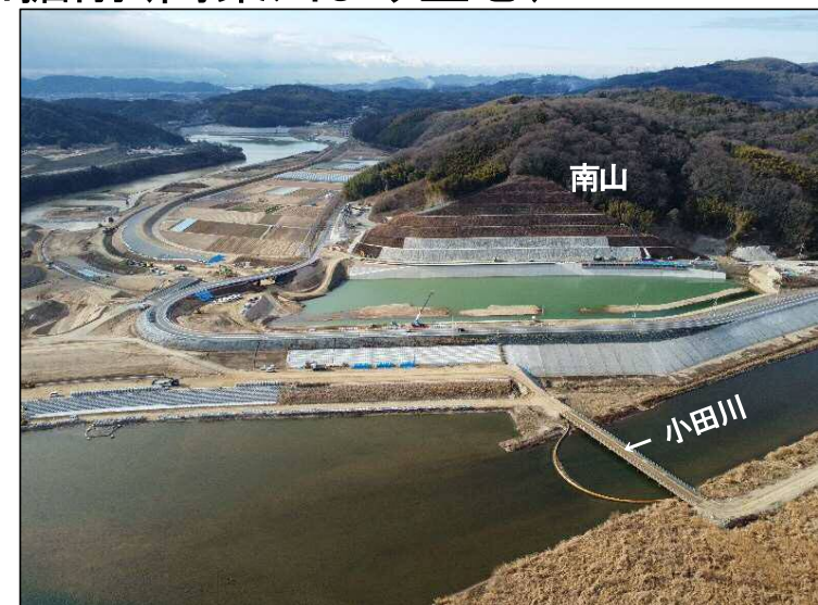
②南山掘削(高梁川より望む)
