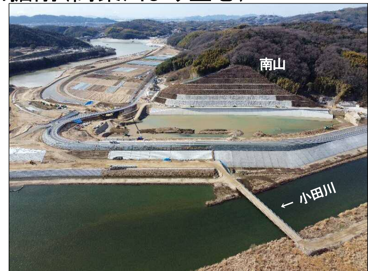
②南山掘削(高梁川より望む)
