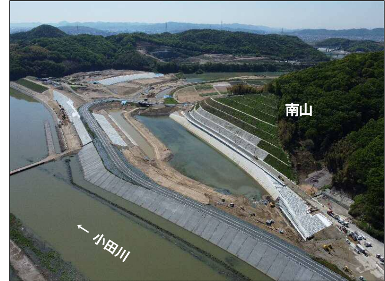
①南山掘削(上流より望む)
