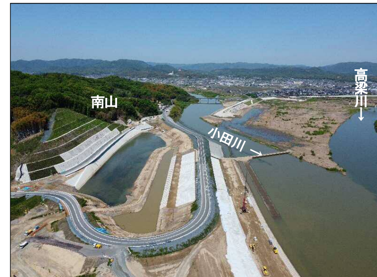
③南山掘削(下流より望む)
