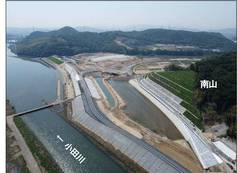
①南山掘削(上流より望む)
