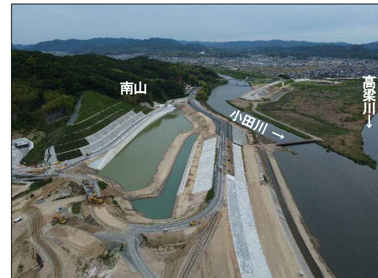
③南山掘削(下流より望む)
