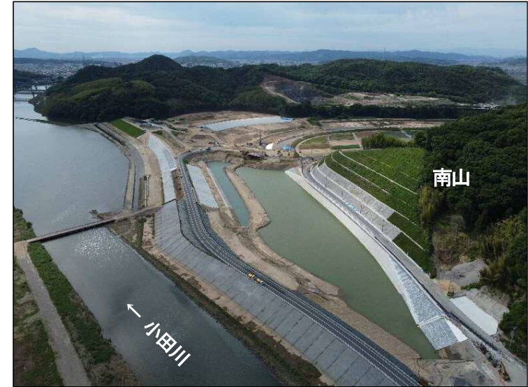
①南山掘削(上流より望む)
