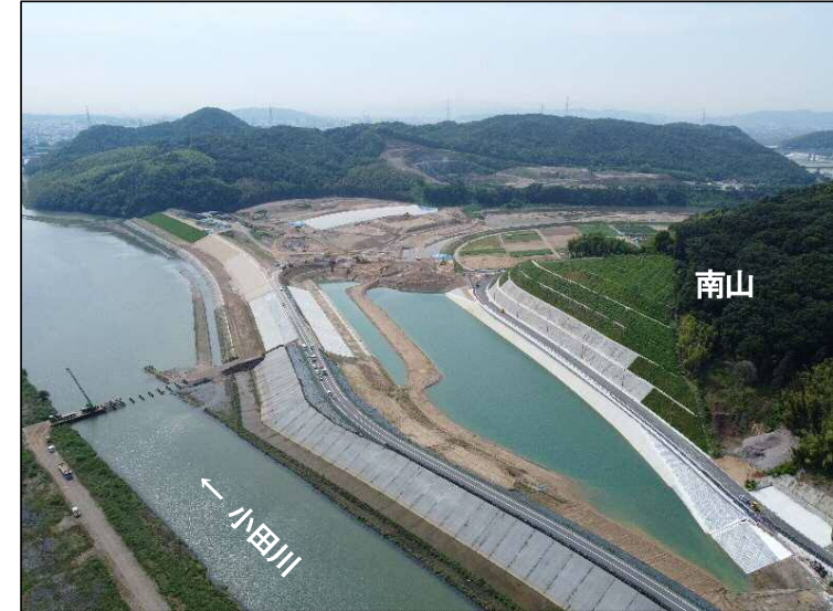
①南山掘削(上流より望む)
