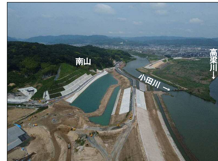
③南山掘削(下流より望む)
