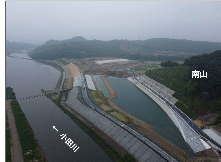
①南山掘削(上流より望む)
