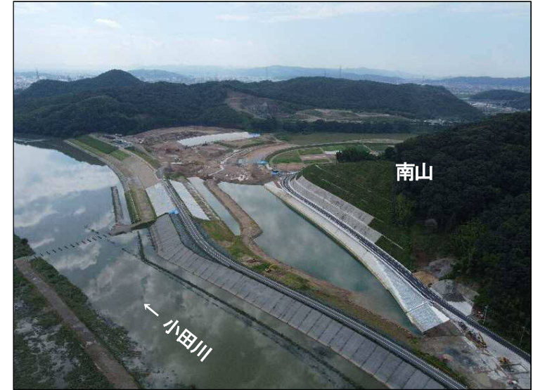
①南山掘削(上流より望む)
