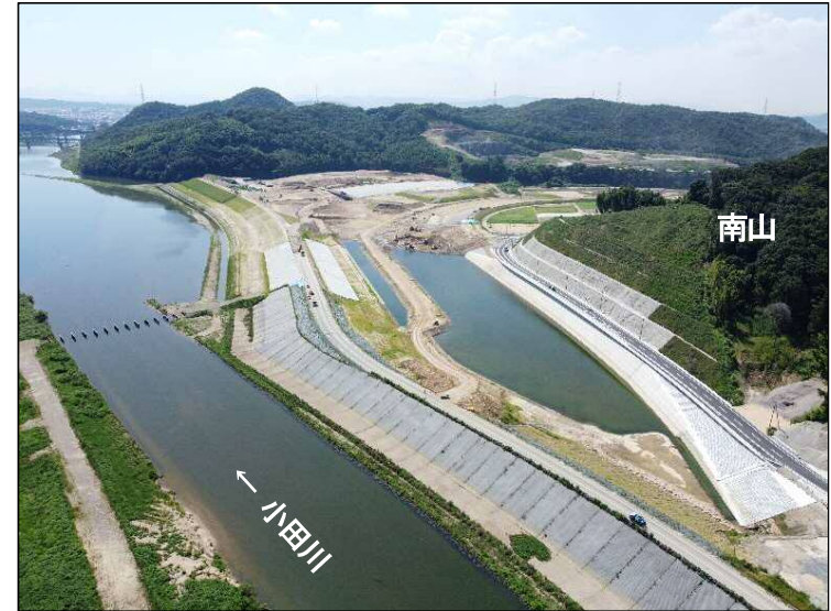
①南山掘削(上流より望む)
