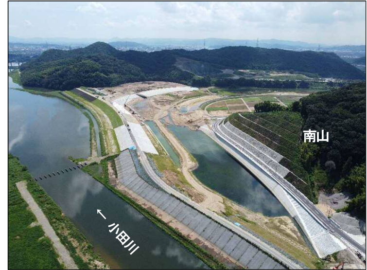
①南山掘削(上流より望む)
