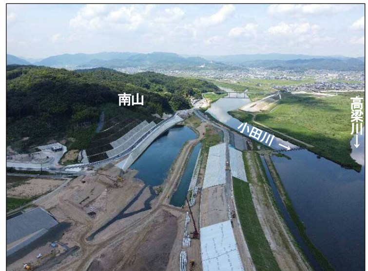
③南山掘削(下流より望む)
