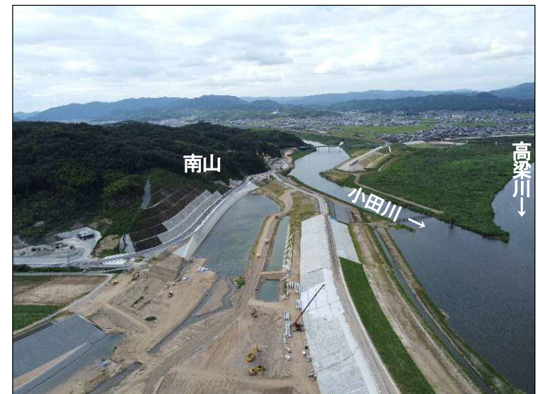
③南山掘削(下流より望む)
