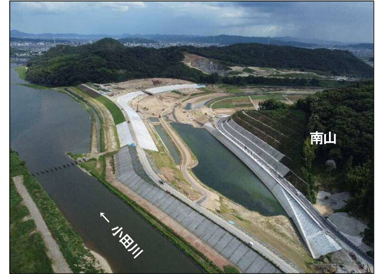
①南山掘削(上流より望む)
