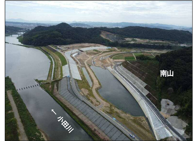
①南山掘削(上流より望む)
