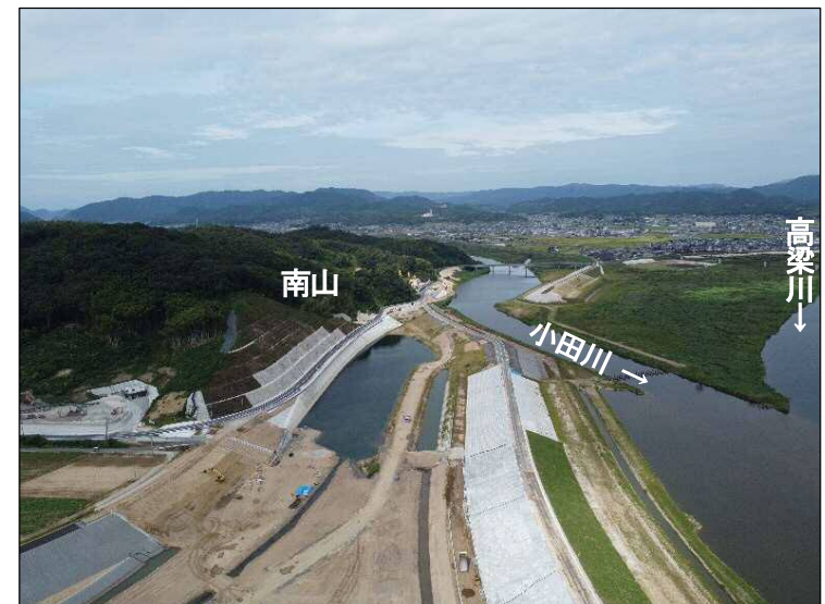
③南山掘削(下流より望む)
