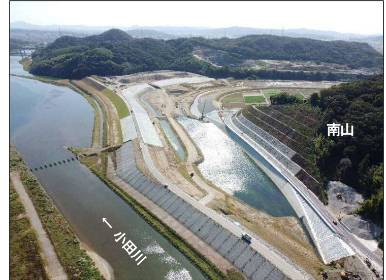
①南山掘削(上流より望む)
