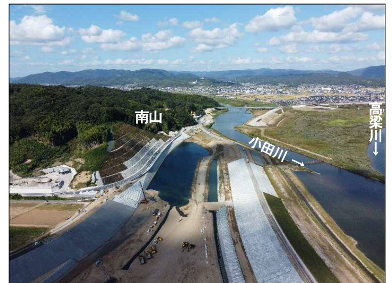
③南山掘削(下流より望む)
