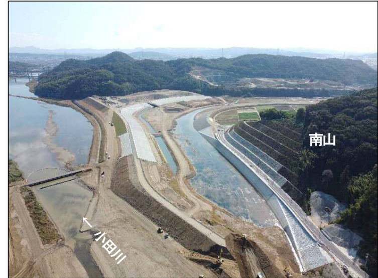
①南山掘削(上流より望む)
