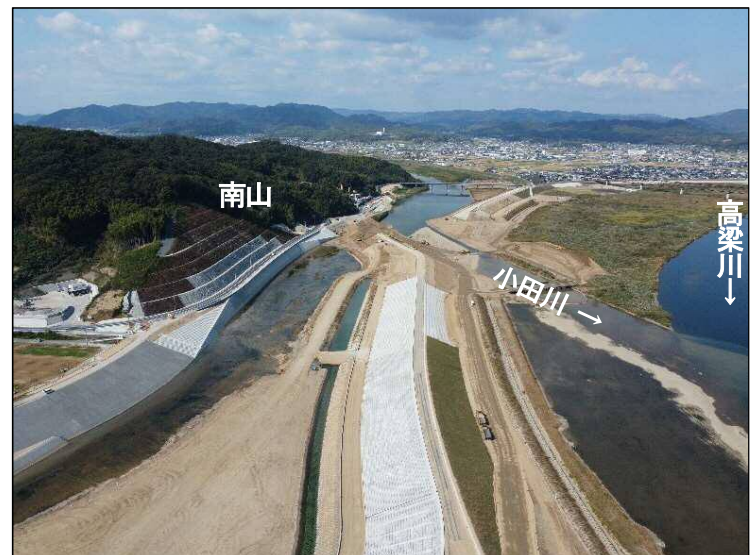
③南山掘削(下流より望む)
