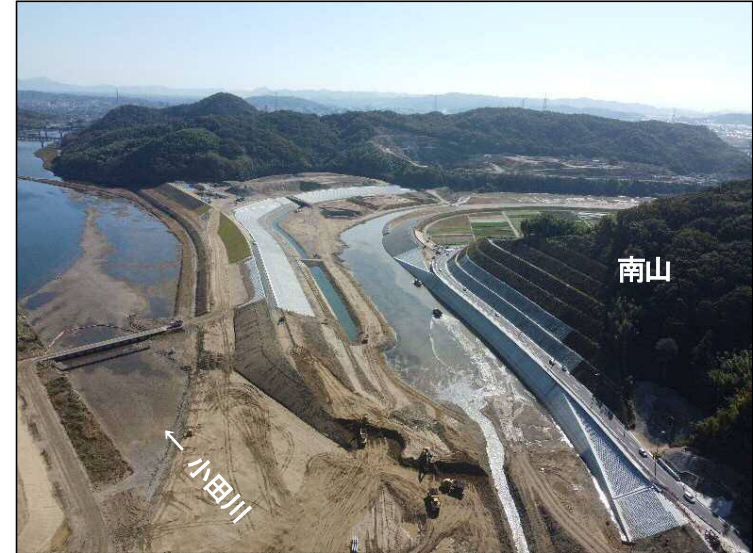
①南山掘削(上流より望む)
