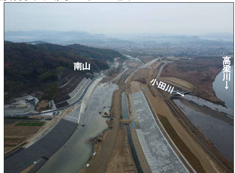
③南山掘削(下流より望む)
