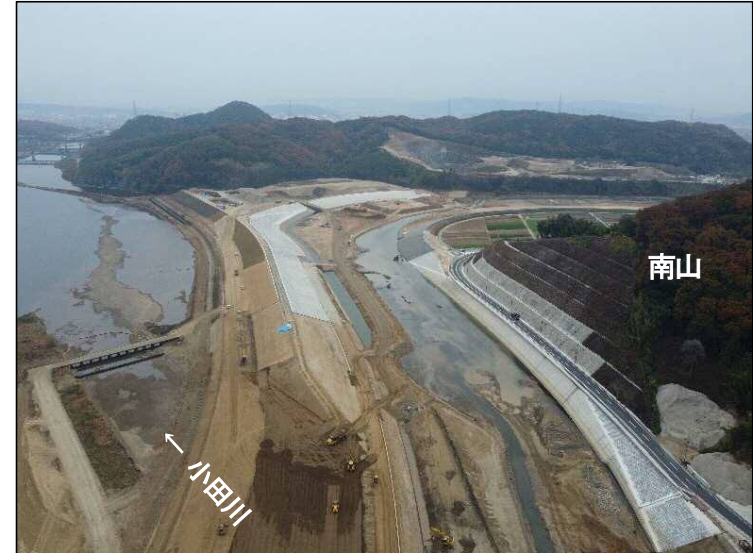
①南山掘削(上流より望む)
