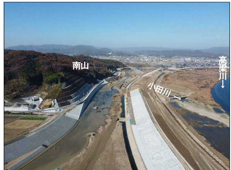
③南山掘削(下流より望む)
