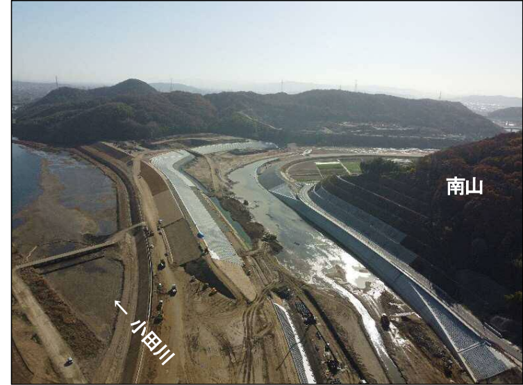
①南山掘削(上流より望む)
