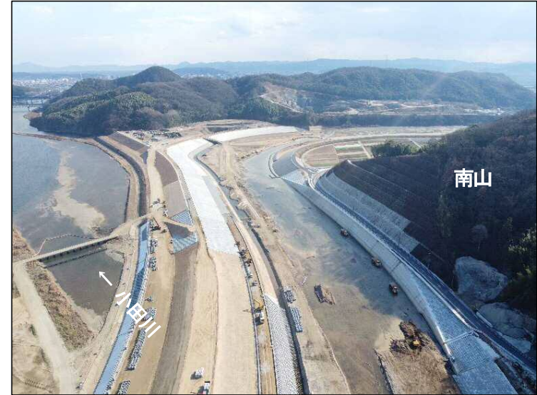
①南山掘削(上流より望む)
