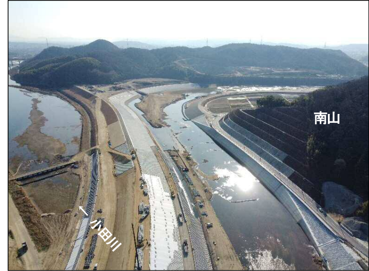
①南山掘削(上流より望む)
