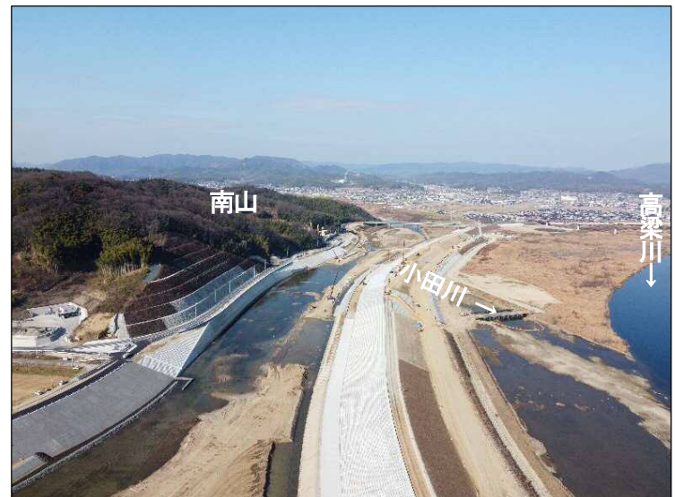
③南山掘削(下流より望む)
