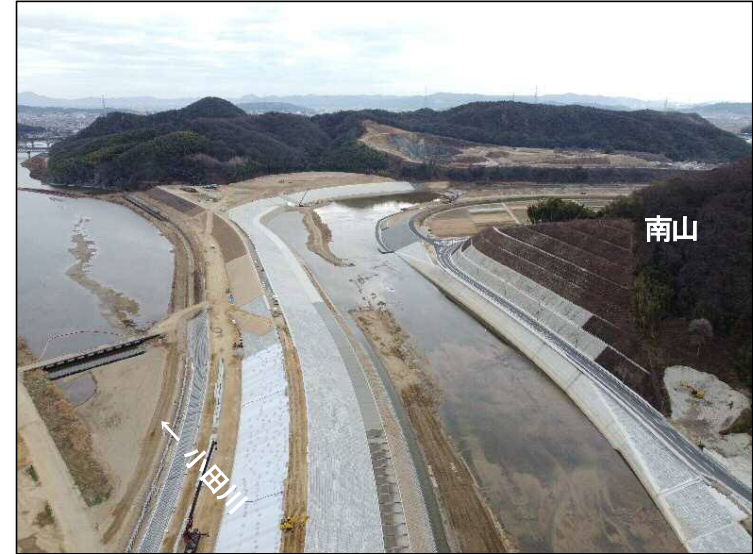
①南山掘削(上流より望む)
