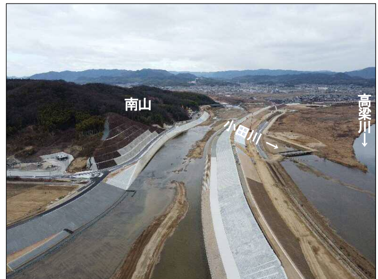
③南山掘削(下流より望む)
