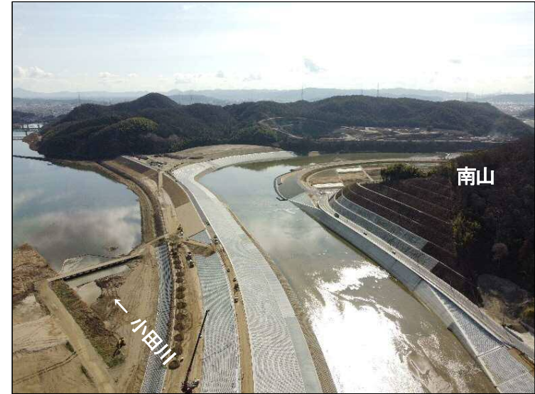
①南山掘削(上流より望む)
