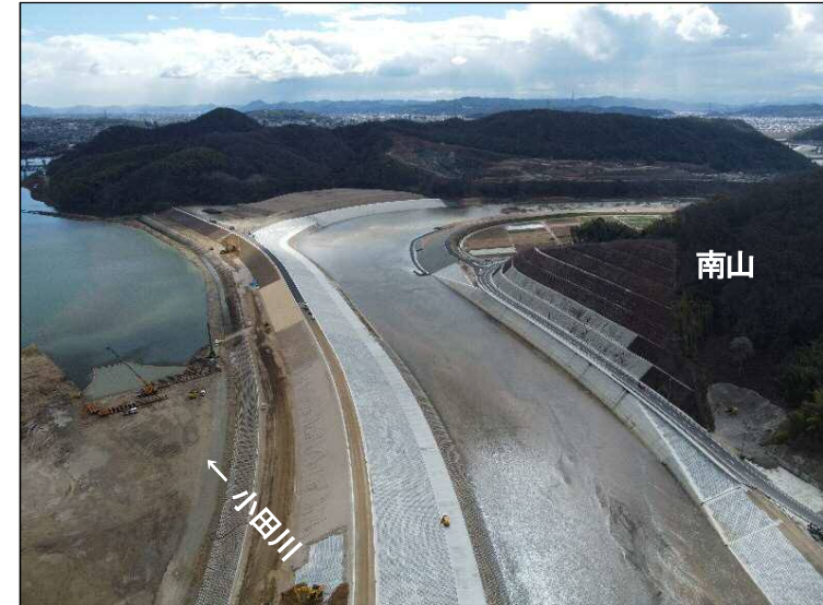
①南山掘削(上流より望む)
