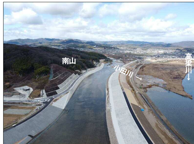
③南山掘削(下流より望む)
