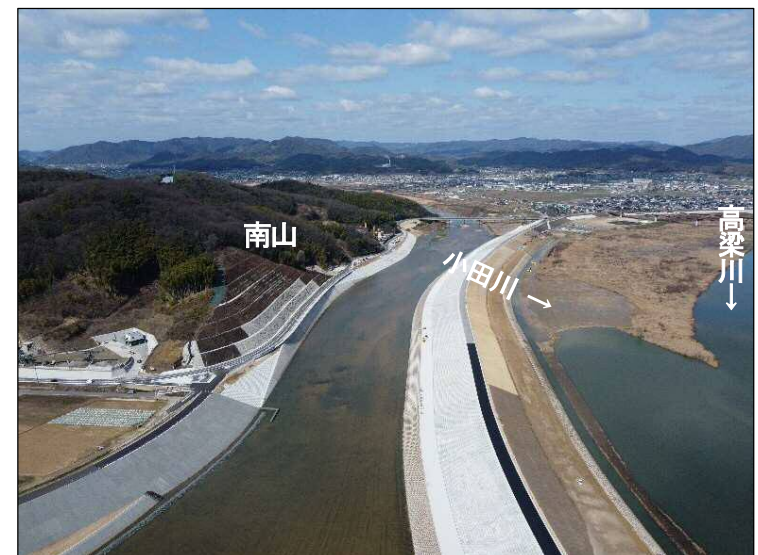
③南山掘削(下流より望む)
