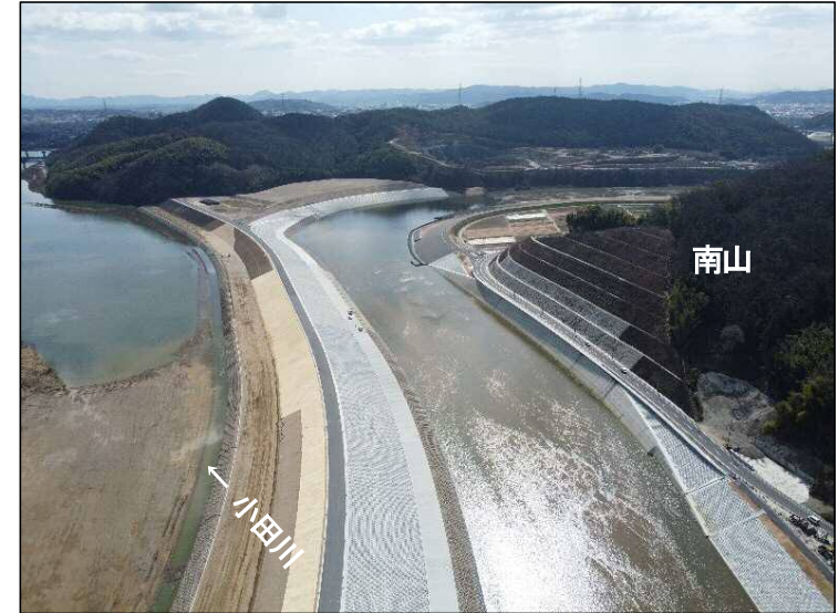
①南山掘削(上流より望む)
