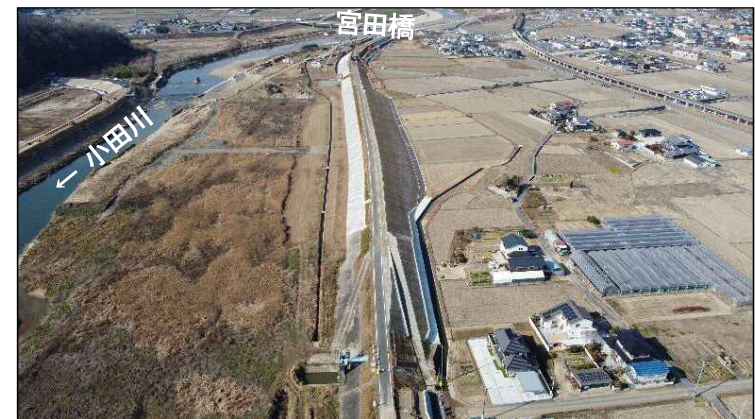
②堤防強化区間(下流より望む)
