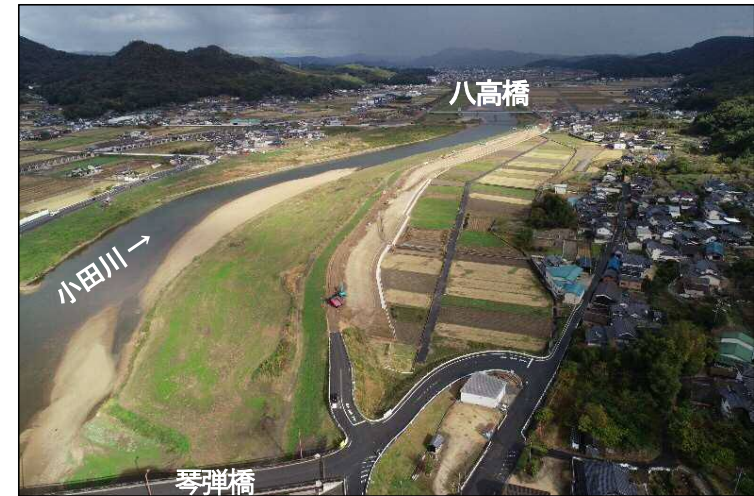
①堤防強化区間(上流より望む)
