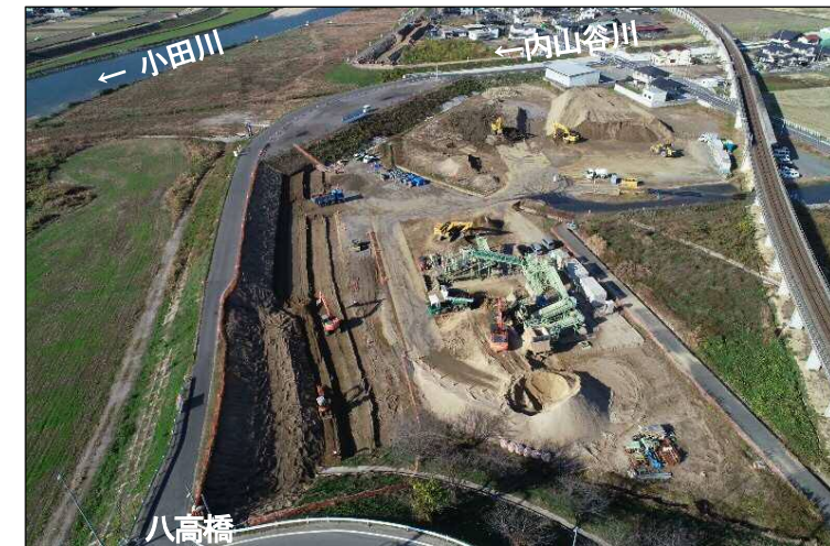
③堤防強化区間(下流より望む)
