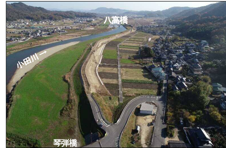
①堤防強化区間(上流より望む)
