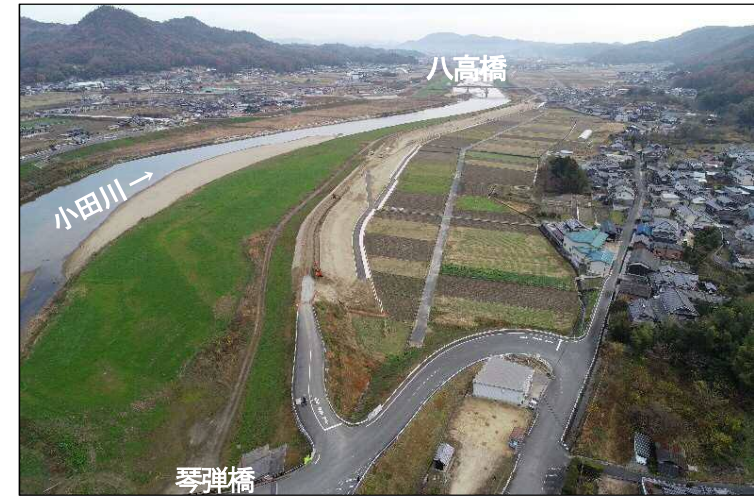
①堤防強化区間(上流より望む)
