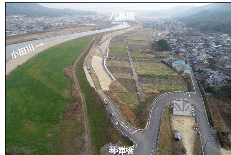
①堤防強化区間(上流より望む)
