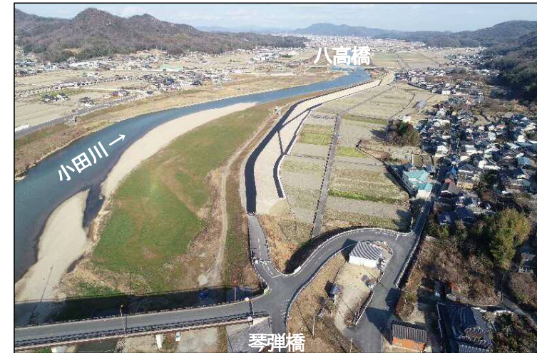
①堤防強化区間(上流より望む)
