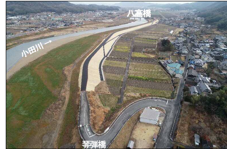
①堤防強化区間(上流より望む)
