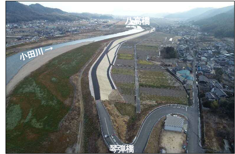
①堤防強化区間(上流より望む)
