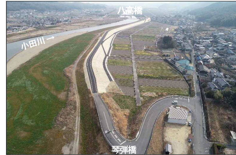
①堤防強化区間(上流より望む)
