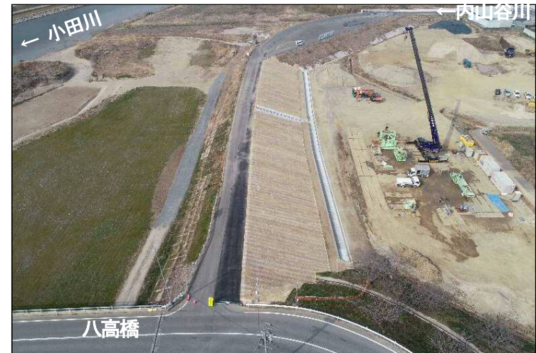
③堤防強化区間(下流より望む)
