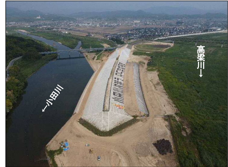
①締切区間(下流より望む)
