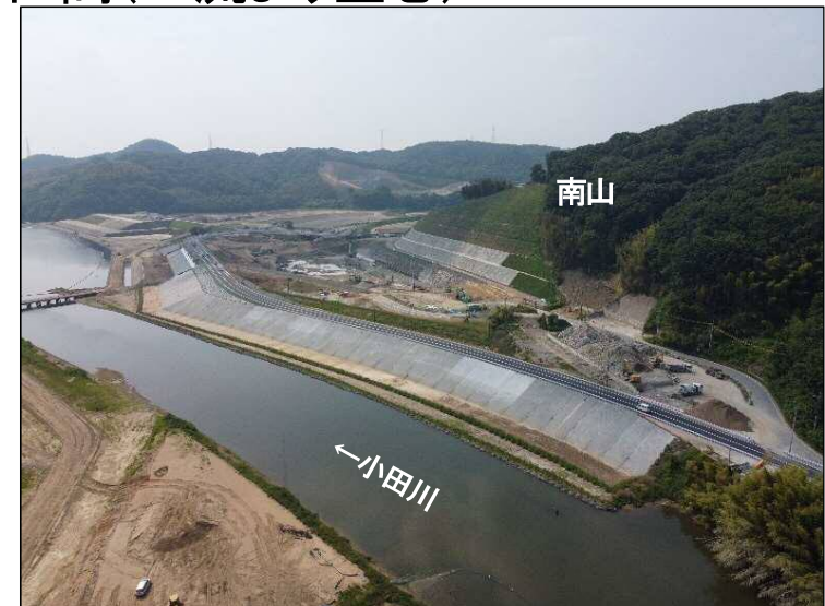
③締切区間(上流より望む)
