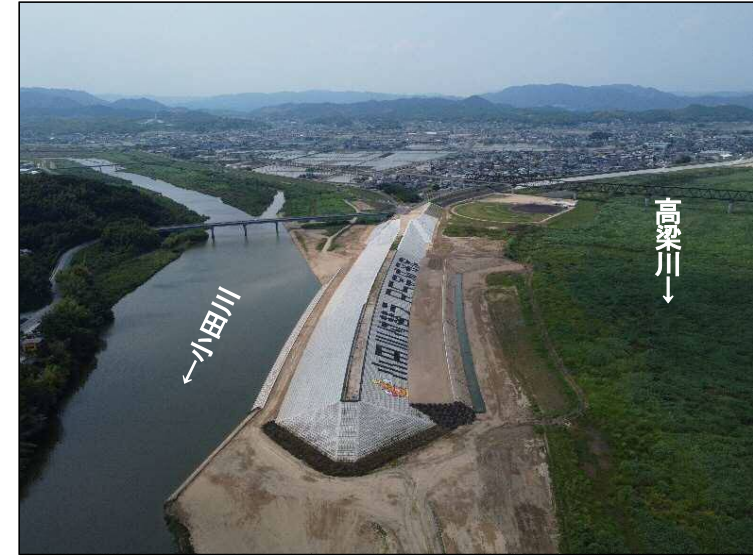
①締切区間(下流より望む)
