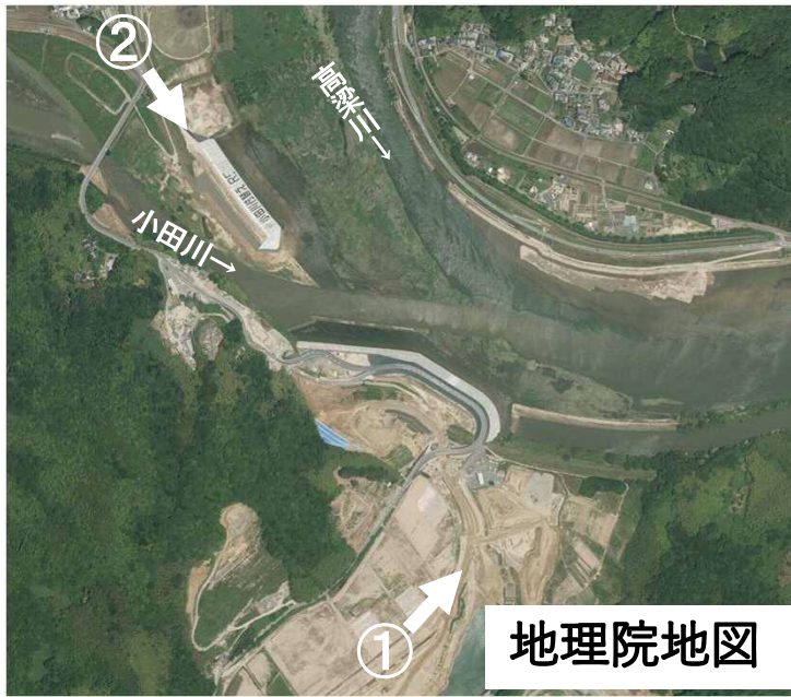
①掘削区間(下流より望む)
