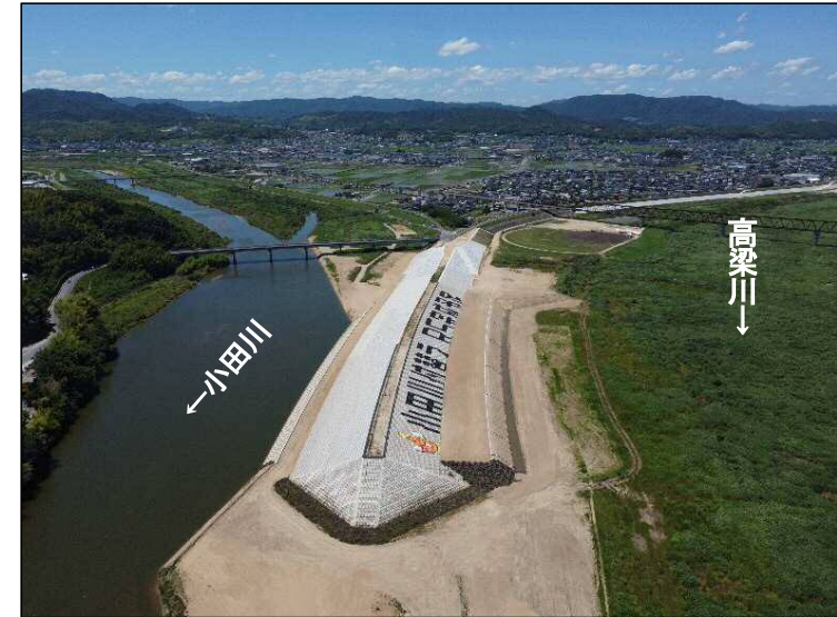
①締切区間(下流より望む)
