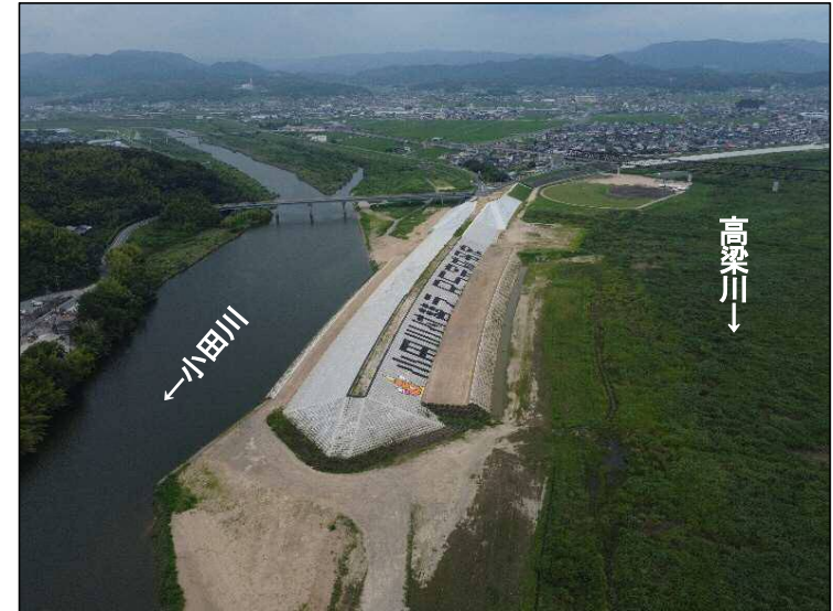
①締切区間(下流より望む)
