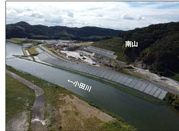
③締切区間(上流より望む)
