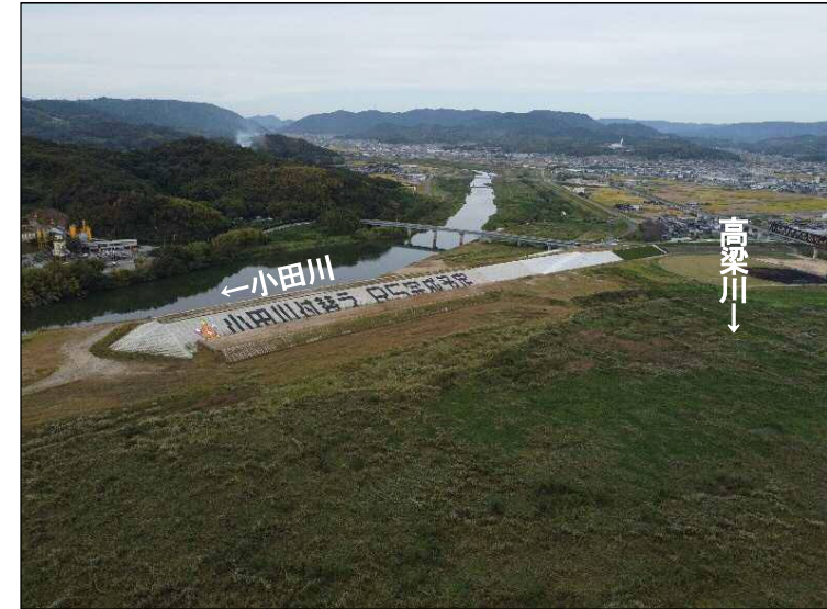
①締切区間(下流より望む)
