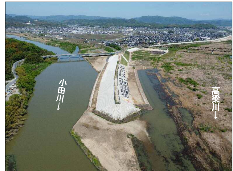
③締切区間(下流より望む)
