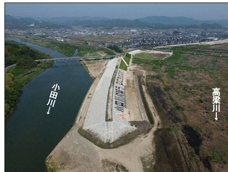
③締切区間(下流より望む)
