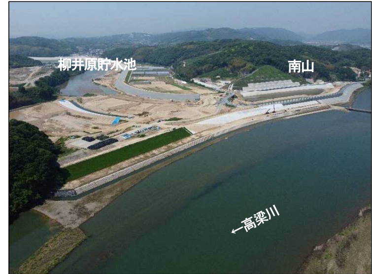
①締切区間(下流より望む)
