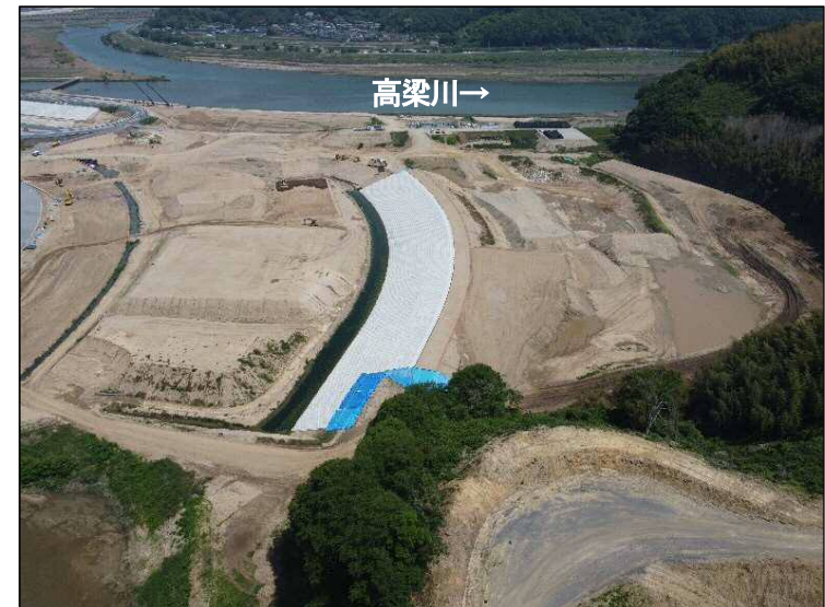
③掘削区間(下流より望む)
