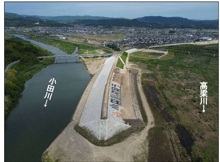
③締切区間(下流より望む)
